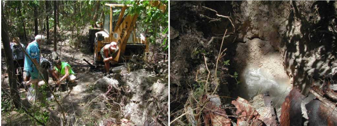
T6 / N°100 et 101 : réalisation d'un sondage au tractopelle au milieu des gravats de l'ancien bâtiment radiochimie, secteur CEA au Sud du village d'Otepa à Hao, vue du fond de fouille (eau E4) . CRIIRAD, le 12 octobre 2005.
