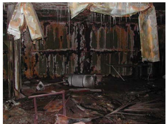
T5 / N°107 et 108 : Intérieur délabré de l'un des blockhaus destinés à protéger la population contre l'irradiation externe liée aux explosions atmosphériques à Tureia. CRIIRAD, le 10 octobre 2005.
