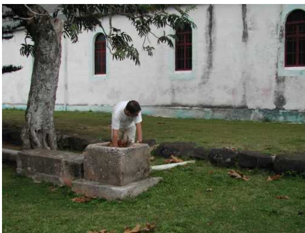
T2 / N°68 : Contrôles radiamétriques dans un regard du système de canalisation des eaux de toiture de la cathédrale de Rikitea. CRIIRAD, le 5 octobre 2005.
